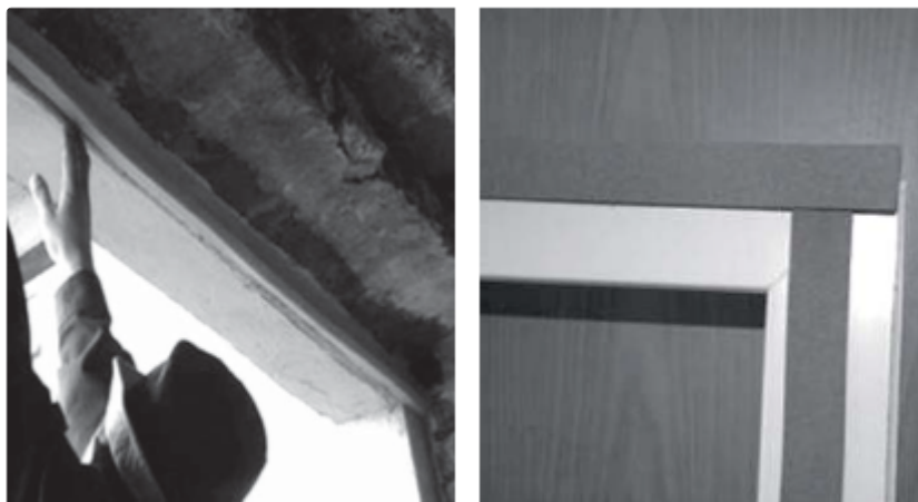
Рис. 7.6.4.3. Наклейка паропроницаемой саморасширяющейся уплотнительной ленты (слева) и водозащитной паропроницаемой мембранной ленты (справа).
