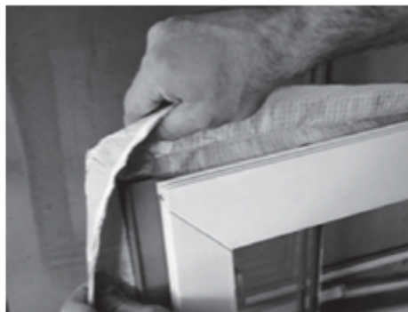
Рис. 7.6.4.4. Крепление пароизоляционной ленты к торцу коробки.
